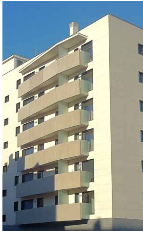
42 RESIDENCIAS BACARDI PROJECT
